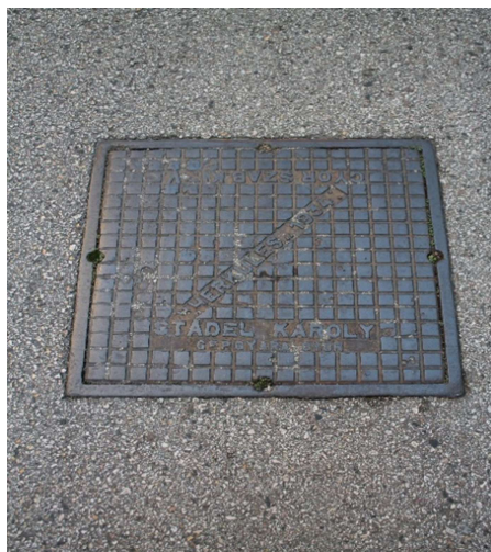
5. kép: Herkules típusú csatornafedél a Batthyány téren. Felirat: „Herkules” 1934: Stádel Károly Gépgyára Győr; Győr. Szab. Kir. V. Forrás: Lanczendorfer Zsuzsanna fotója, Győr, 2022.
